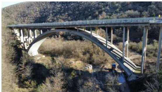
Figura 3-10 Tipologie di ponti ad arco in calcestruzzo
