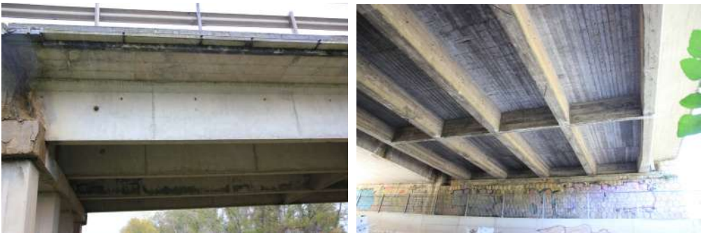
Figura 3-12 Esempi di impalcati con travi e traversi in c.a.
