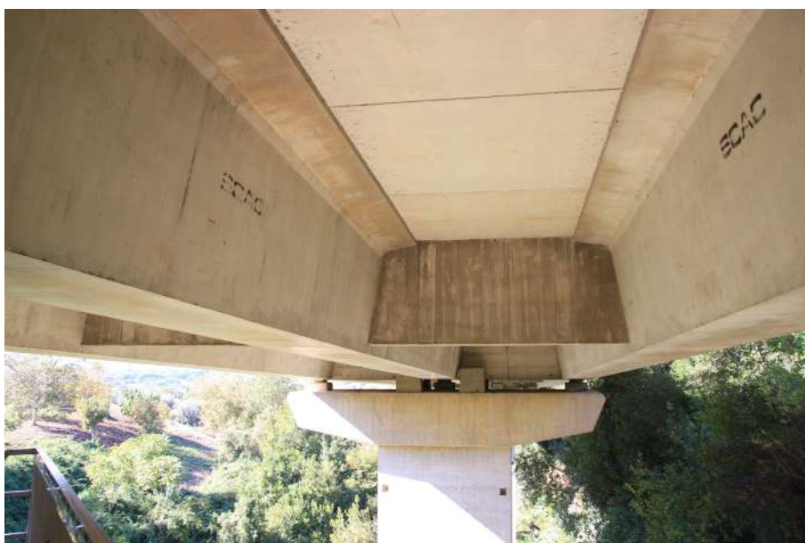
Figura 3-15 Esempi di impalcati con travi in c.a.p.
