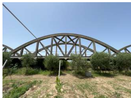
Figura 3-10 Tipologie di ponti ad arco in calcestruzzo
